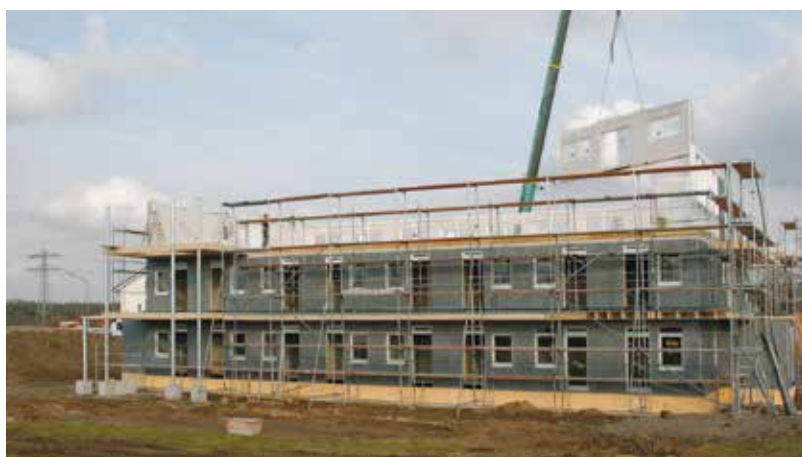
Edificio multipiano realizzato in legno con pannelli intelaiati rivestiti con lastre di gessofibra FERMACELL.
